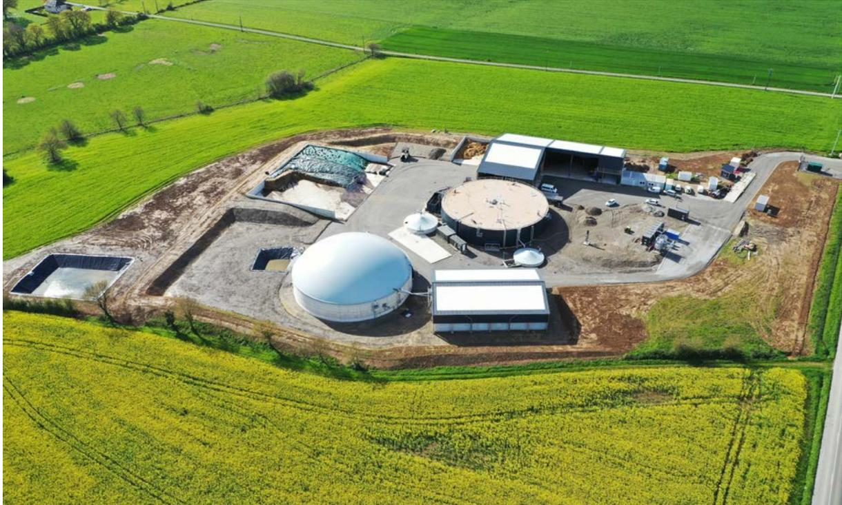
**Image :** BIOGEST 135 Nm<sup>3</sup>/h (41 857 MMBTU/an) Anneau de puissance biométhane usine dans Congrier, FR
